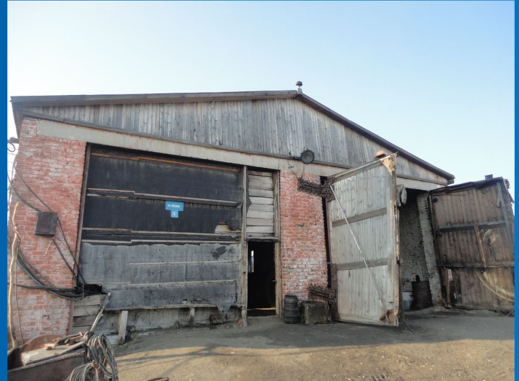
Дизельная электростанция в п. Хета (Красноярский Край).
